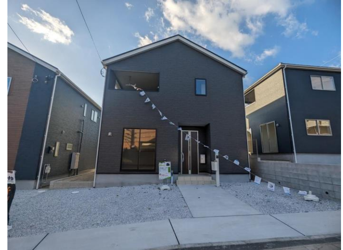
現地外観写真 現地(2023年11月)撮影
